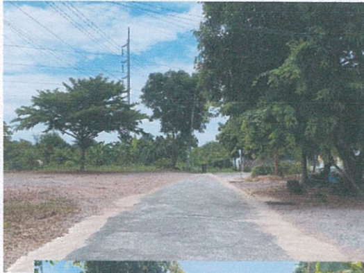
โครงการก่อสร้างเสริมผิวแอสฟัลท์ติก ถนนเทศบาล ๘ หมู่ ๙ ชุมชน ดอนเผ่าสมสามัคคี
