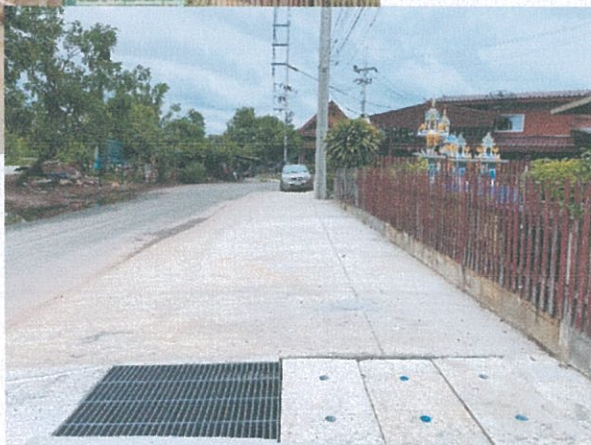
โครงการก่อสร้างถนนคอนกรีตเสริมเหล็กพร้อม รางระบายน้ำบริเวณบ้านนายจรัล เอกสาร
